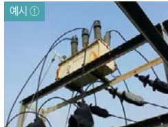
ASS 상태 확인(외부용) * H변대에 올라가서 확인하지 마십시오.
