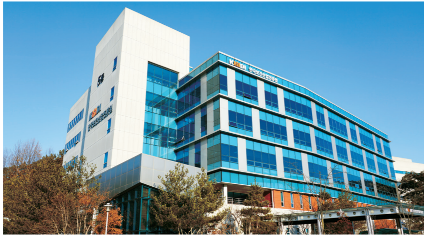
청주 오송읍에 위치한 한국보건산업진흥원 전경.
