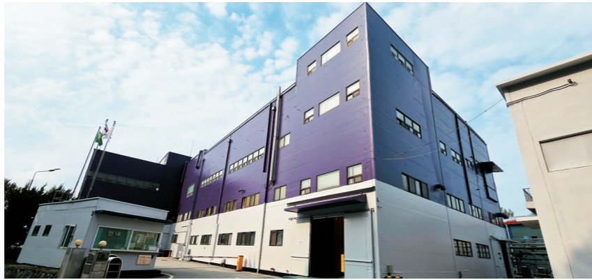
음성군에 위치한 네패스 EM사업부 전경.
