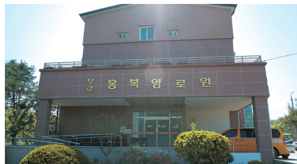
음성군 생극면에 위치한 행복양로원 전경.
